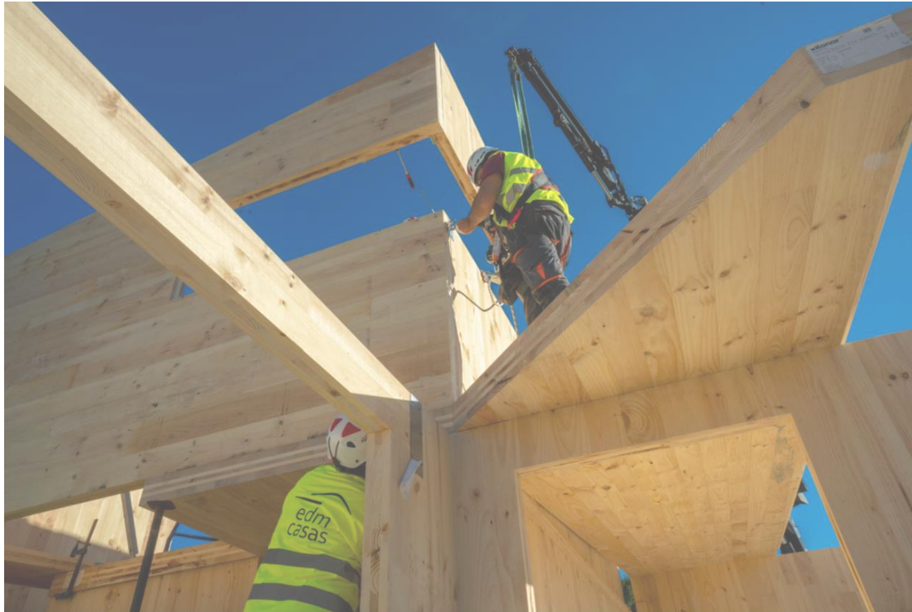
FOTO: Casa Biduido (arquitecta Marta Trigás)
